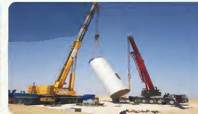
Primjer postavljanja vjetroturbine (WTG) na betonski temelj pomoću kрана
