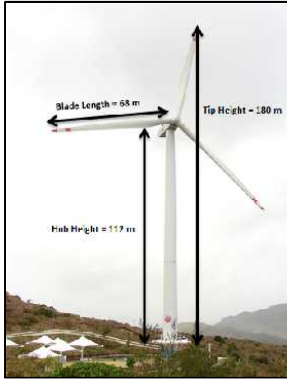
الشكل 2: منظر توربينة رياح نموذجية يبين ارتفاع الحد الأقصى للمروحة 180 م
